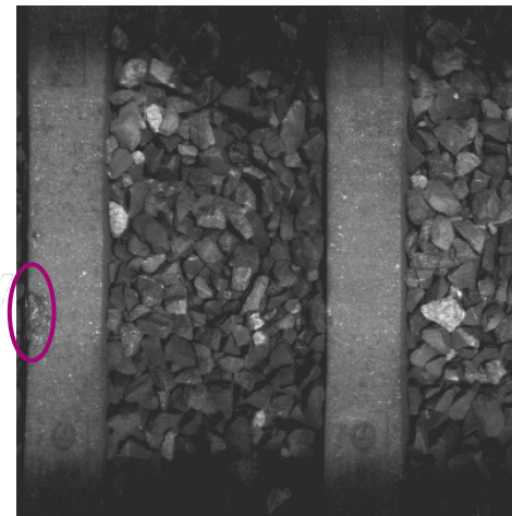
Spalling
